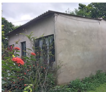
VIVIENDA EN PROCESO
