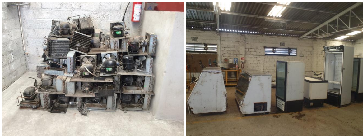
Figura 5 Buenas prácticas de manejo de los equipos de refrigeración
